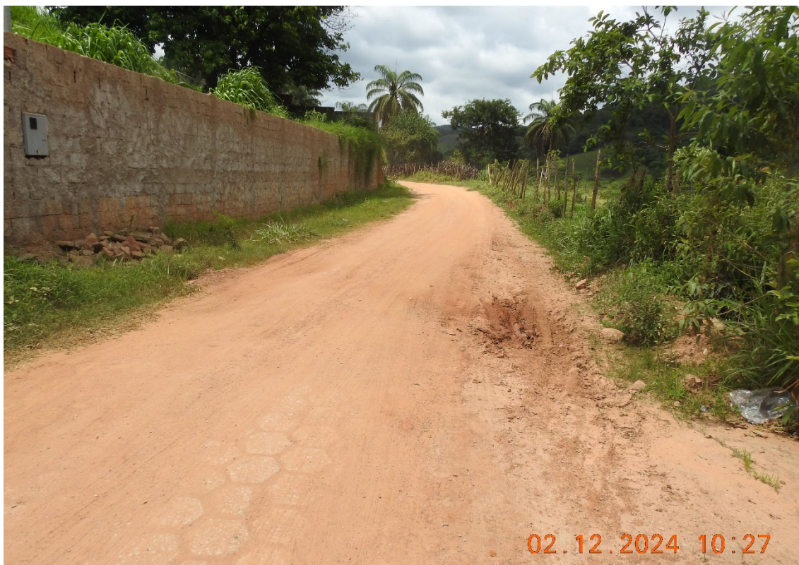
Foto 3: Vista do ponto inicial do trecho da Rua Antônio Linhares a ser pavimentado.
