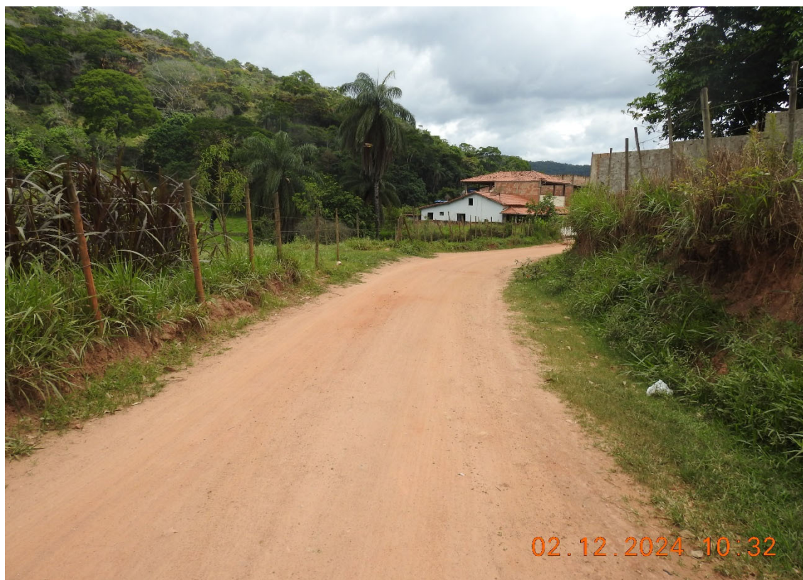
Foto 4: Ponto intermediário do trecho a ser pavimentado.
