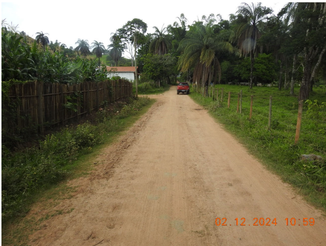
Foto 9: Outro trecho da Rua Antônio Linhares a ser pavimentado.
