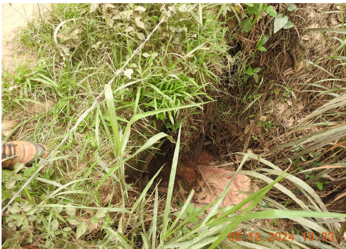
Foto 6: Drenagem existente próximo à entrada da propriedade do Sr. Mário Luiz.
